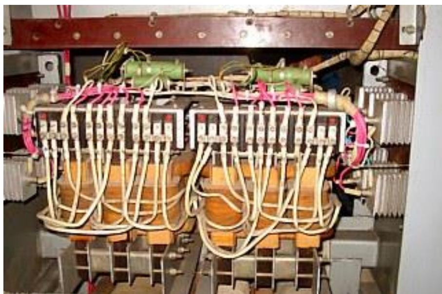
Принцип действия магнитного усилителя основан на использовании нелинейности кривой намагничивания ферромагнитного материала. При намагничивании постоянным током сердечник усилителя насыщается и индуктивность рабочих обмоток переменного тока усилителя уменьшается. Рабочие обмотки обычно включаются последовательно с нагрузкой. Поэтому напряжение, которое до насыщения сердечника было приложено к рабочим обмоткам усилителя в момент насыщения, прикладывается к нагрузке.
